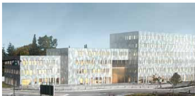
Betonmast - kontorbygg 10.000 m 2 i Trondheim
