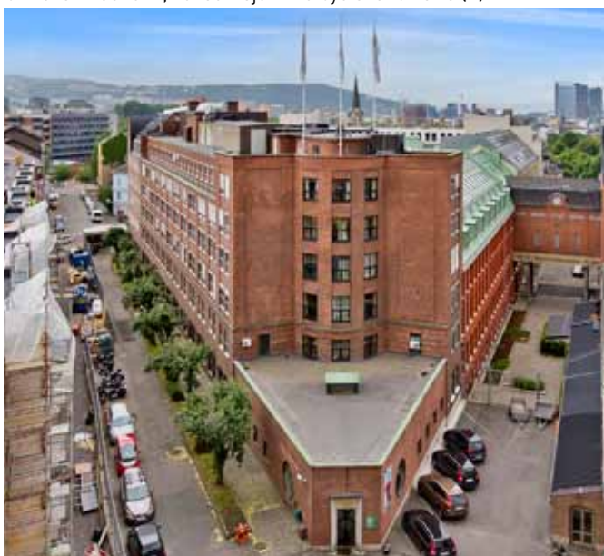
Betonmast: Anker Studentbolig, Rodeløkka. Rehabilitering fra kontor til studentbolig
